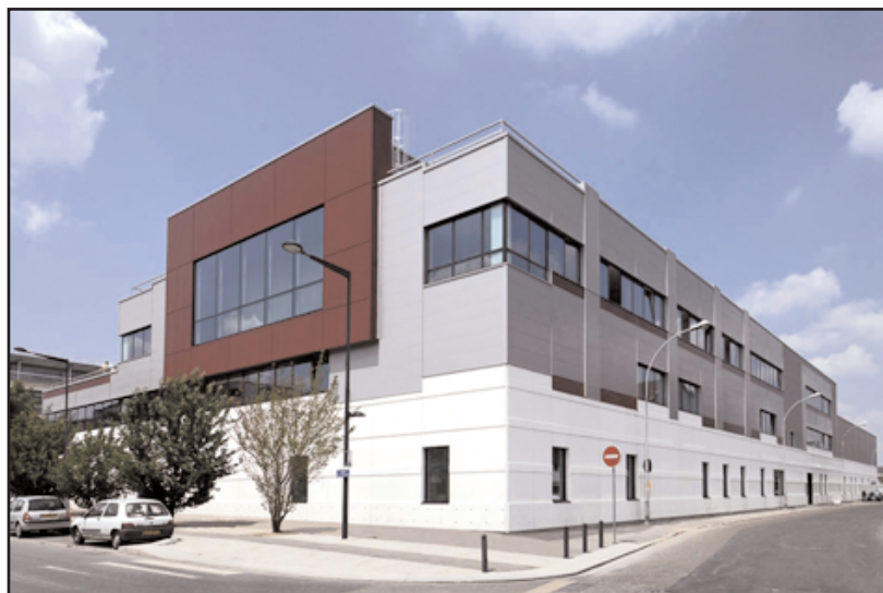
Façade de l'immeuble TSF rue des Fillettes à La Plaine Saint-Denis
