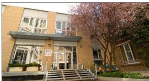
façade intérieure du site de Digimage à Montrouge Document Digimage/AFC
