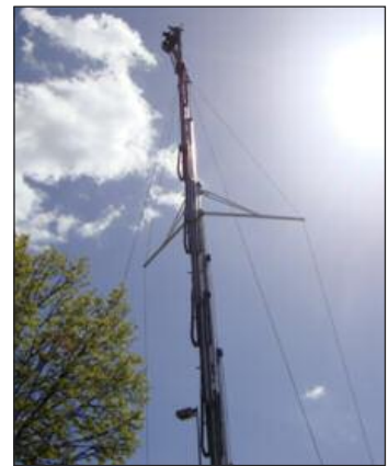
... et la tête 2 axes, à environ 30 mètres de hauteur - Photos ACS France
