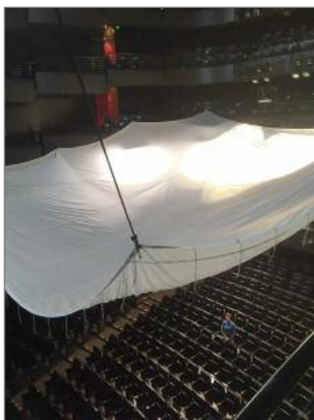
Installation du velum dans la salle de l'Opéra de Lyon Le décor de l'Opéra avec Philippe Leroy, chef électricien, assis en bas sous le grand velum de 12x12 m tendu la veille du tournage (c'est le plus grand qu'on ait trouvé). Des découpes et PC de l'Opéra déjà fixés par les électriciens de l'Opéra donnaient l'effet d'éclairage de la salle - Photo Ahmed Zaoui
