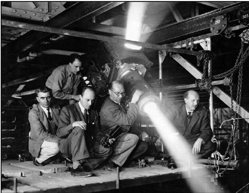
Cardiff et Powell à côté d'une poursuite à arc de 300 ampères mise au point pour le ballet de Red Shoes (voir photogramme correspondant page suivante)
