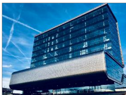
IBC vu de l'extérieur
